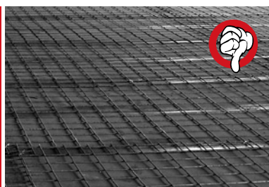
Tradiční cementový potěr - vyžaduje vyztužení
