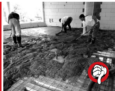
Pokládka tradičního cementového potěru
