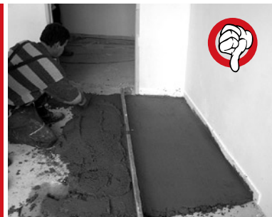
Hlazení tradičního cementového potěru
